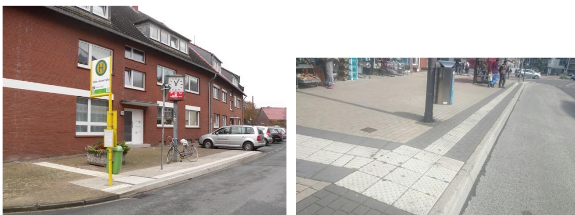
Abbildung 7: Beispiele für Haltestellen mit Bodenindikatoren nach aktuellem „Stand der Technik“ (links: Datteln, Schmiedestraße; rechts: Marl, Römerstraße (Quelle: Kobra nvs GmbH))
