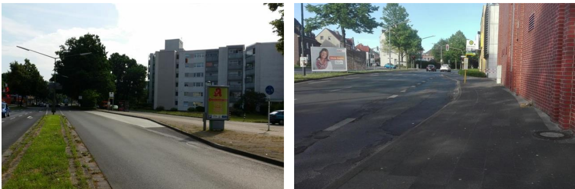
Abbildung 5: Beispiele für Busbuchten mit zu kurzer Ausbildung ermöglichen kein spaltfreies Anfahren der Haltestellenkante (links: Marl, Paracelsusklinik; rechts: Herten, Rathaus (Quelle: Kobra nvs GmbH))
