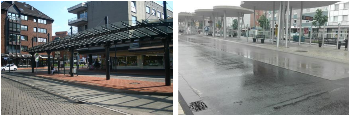
Abbildung 4: Beispiele für zentrale Haltestellen mit hohem Ausbauzustand (links: Castrop-Rauxel, Münsterplatz; rechts: Herten, Mitte (Quelle: Kobra nvs GmbH))
