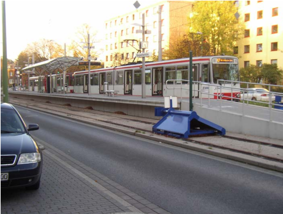
■ Abbildung 19: Stadtbahn-Haltestelle Margarethenhöhe (U17)
