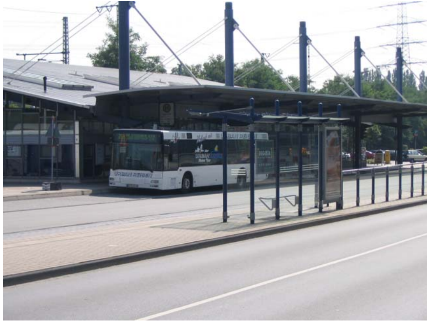
■ Abbildung 15: Bottrop Hbf. – Haltepositionen in Richtung Innenstadt im Bahnhofsbereich
